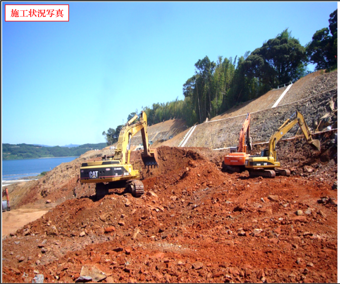
施工状況写真
