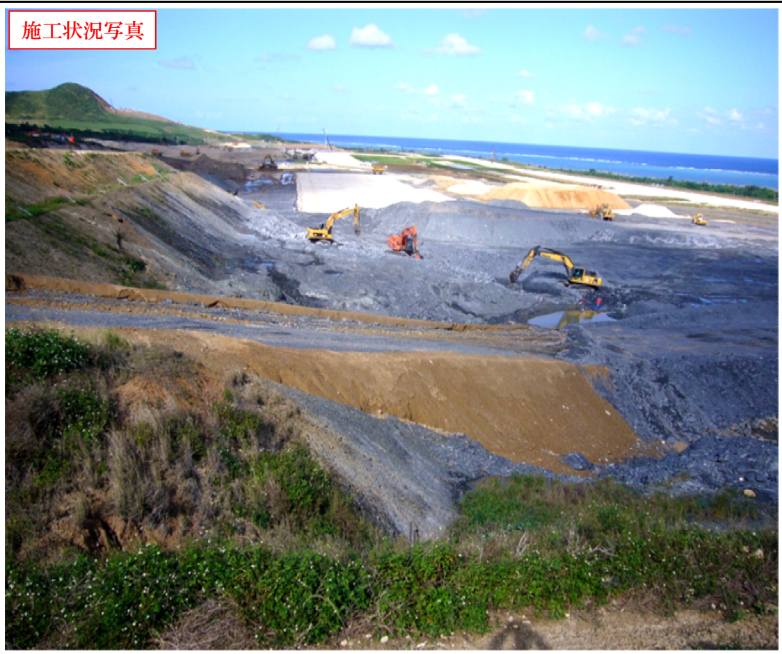
施工状況写真
